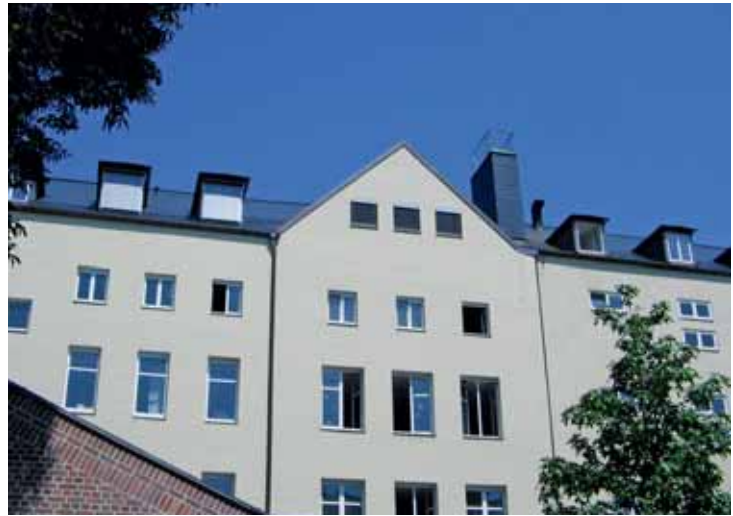
Regensburg: Marienschulen (Umbau)
