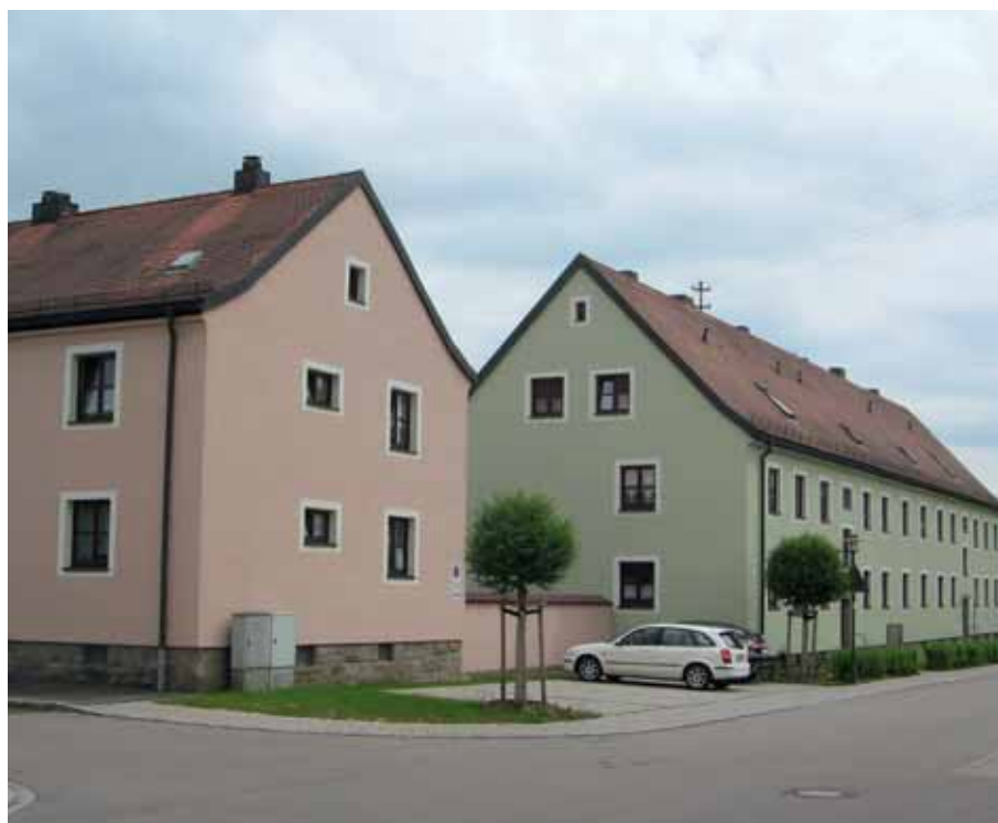
Wiesau: Karree Friedenstraße/Marktstraße (Fassaden- und Heizungsanierung)
